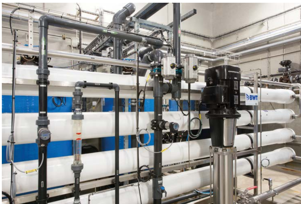
Installation BWT - 20 m 3 /h de production d'eau déminéralisée par osmose inverse en industrie agroalimentaire.
