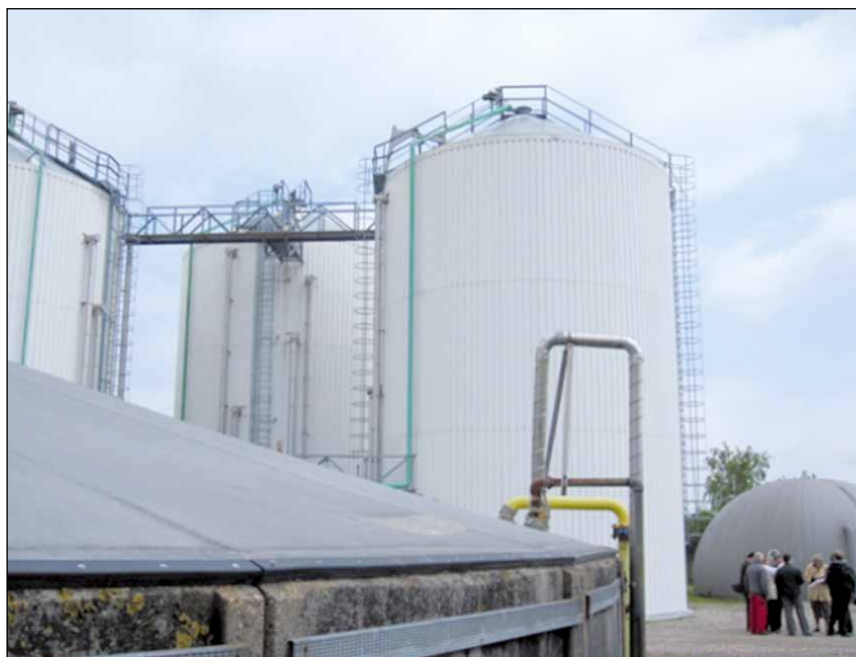
Figure 2: Les réservoirs verticaux en acier pour la digestion des déchets mixtes de l'agriculture et de l'industrie au Danemark
