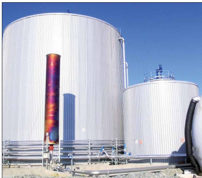
Figure 8: La conception industrielle d'un digesteur de déchets avec (de droite à gauche) un ballon à gaz, le réservoir de pré-acidification et le digesteur. (Picture courtesy of BDI).
