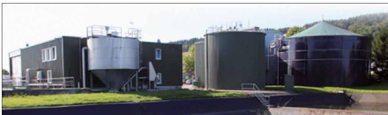
Figure 4: Digestion des déchets végétaux dans un réacteur de contact: Gastro Star, Switzerland (Forster AG)
