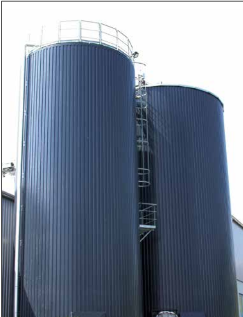
Figure 5: Filtre anaérobie digérant des eaux usées de brasserie: Lupo, Suisses
